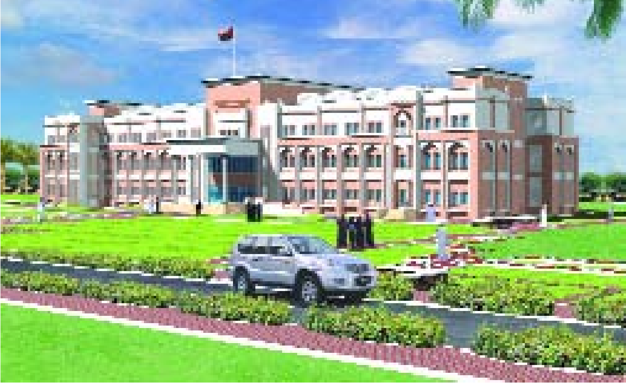
مبنى كلية التجارة والعلوم الإدارية The College of Commerce and Business Administration Building
