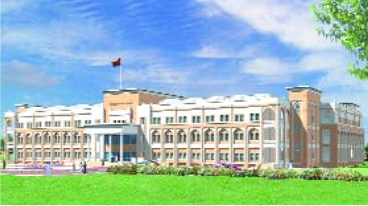
مبنى كلية الآداب والعلوم التطبيقية The College of Arts and Applied Sciences Building
